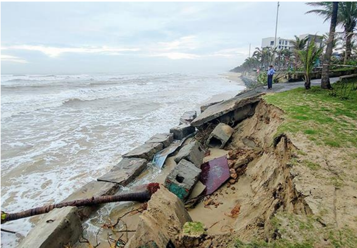
Bờ biển thuộc quận Ngũ Hành Sơn xói lở nghiêm trọng từ cuối tháng 12-2020. Ảnh: TẤN VIỆT
